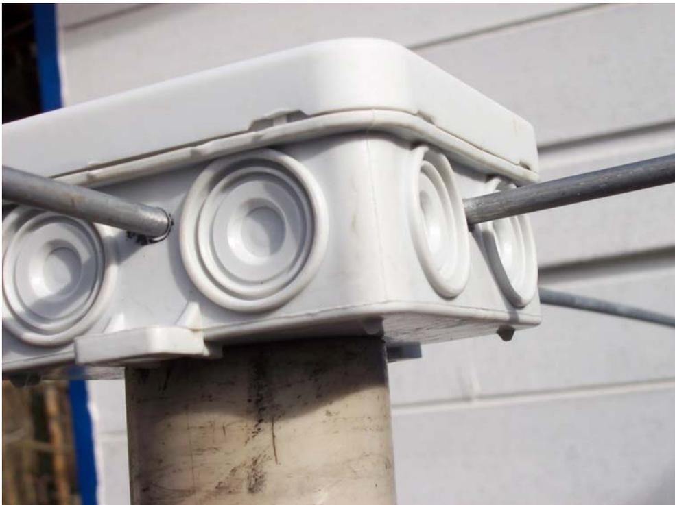
Wenn man die Löcher in der Dose kleiner als den Durchmesser der Dipolelemente bohrt, ergibt sich durch das weiche PVC eine gewisse Regenabdichtung. Zum Schutz vor Schwitzwasser habe ich am Boden zwei weitere Löcher gebohrt, klein genug, dass sich keine Insekten in der Dose einnisten können ;-)
